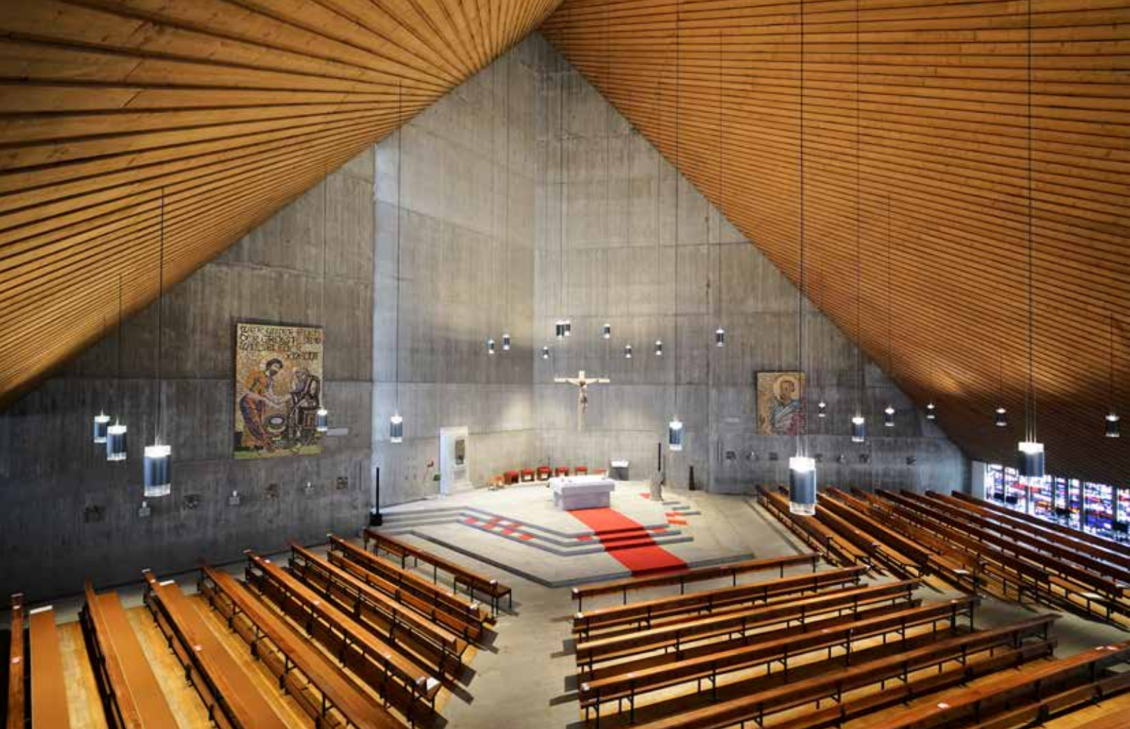
Abbildung 1: Bei den »X.Harmony«-Pendelleuchten lässt sich der Direktlichtanteil unabhängig vom Indirektlicht schalten. Letzteres setzt die expressive, zeltförmige Dachform der Kirche in Szene.
