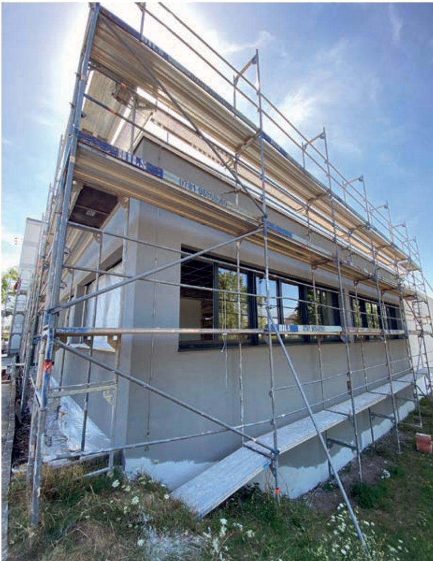
Werthaltige Dämmung der Außenwände mit einem Wärmedämmverbundsystem
