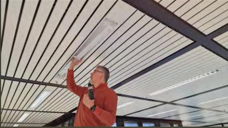
x.change von luxwerk einsetzen, mit Bohrschrauben befestigen und anschließend die Netzleitung anklennen.
