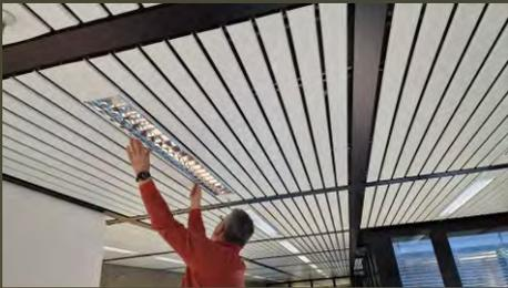
Raster einsetzen und die Sicherung wieder einschalten.
